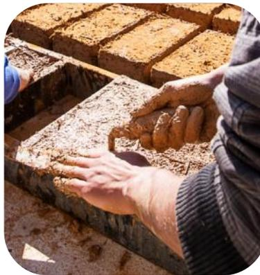
*Lissage de briques fibrées (nivelage manuel, suppression des brins rebels, nettoyage du pourtour du moule, ajout d'eau puis lissage à la truelle)*
