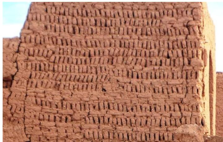
*Mauvais appareillage + absence de joints verticaux (Zagora, Maroc)*
