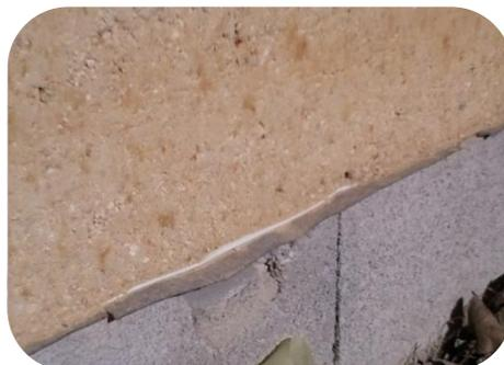
*Principe chapeau/bottes, soubassement en parpaings avec film goudronné sur mur en pisé*
