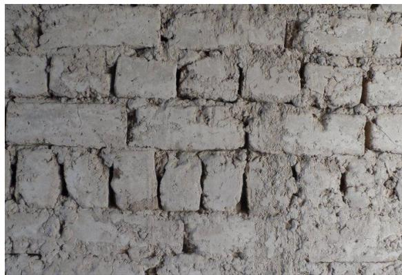
*Mauvais appareillage + absence de joints verticaux (Ouled Driss, Maroc)*
