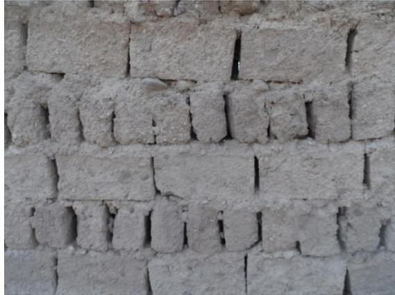
*Mauvais appareillage + absence de joints verticaux (Mhamid, Maroc)*
