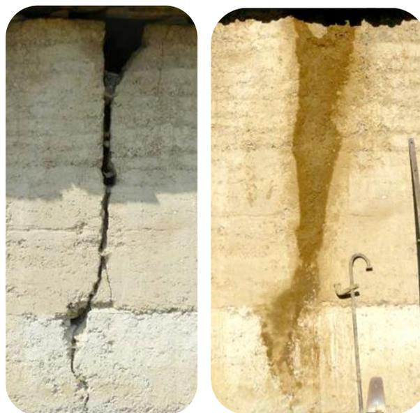
*Rebouchage d'une fissure apparue dans un mur en pisé (NaturaBati)*
