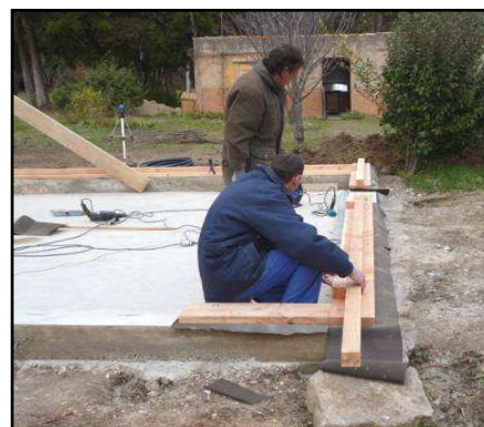
Pose de la base de l'ossature bois
