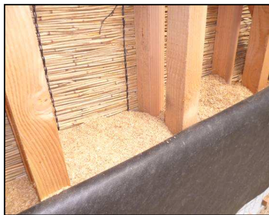
Remplissage des cloisons et du toit
