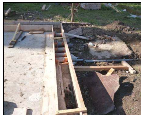
Pose d'écoulements
