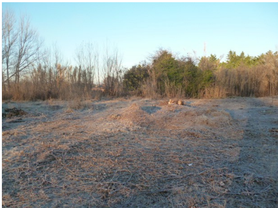
Illustration 4 : Débroussaillage plateforme Hangar
