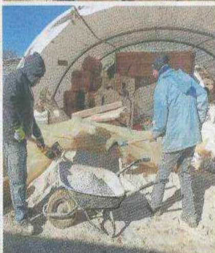
Des salariés en insertion fabriquent des briques de terre compressée. La terre a aussi été utilisée pour construire dix pavillons d'accueil en « pension de famille » (en haut à droite). © AFP
